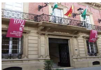
Fachada de la Diputación Provincial de Almería c/ Navarro Rodrigo
