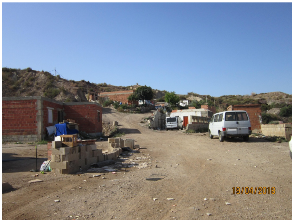
Viviendas en construcción.
