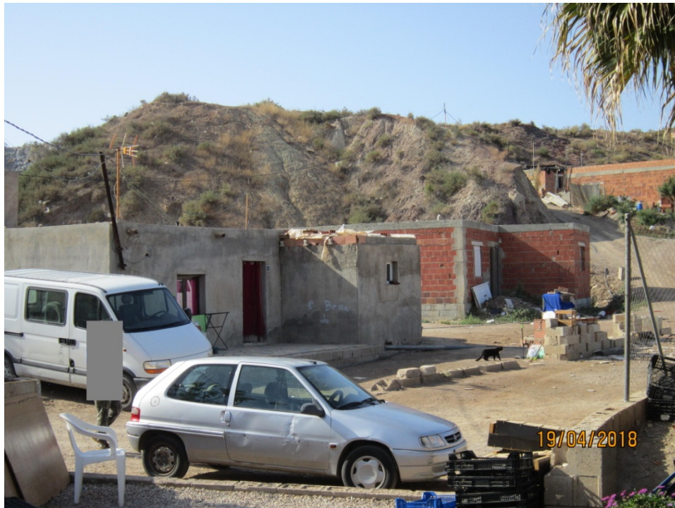
Viviendas en construcción.
