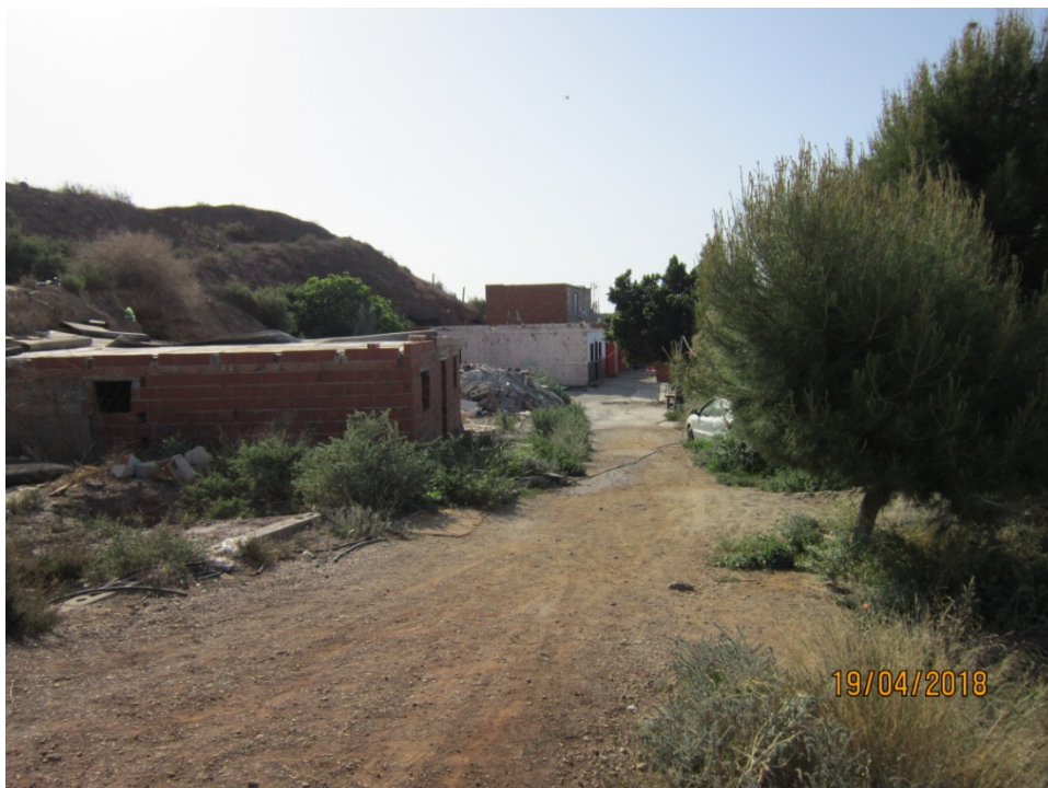
Viviendas en construcción.
